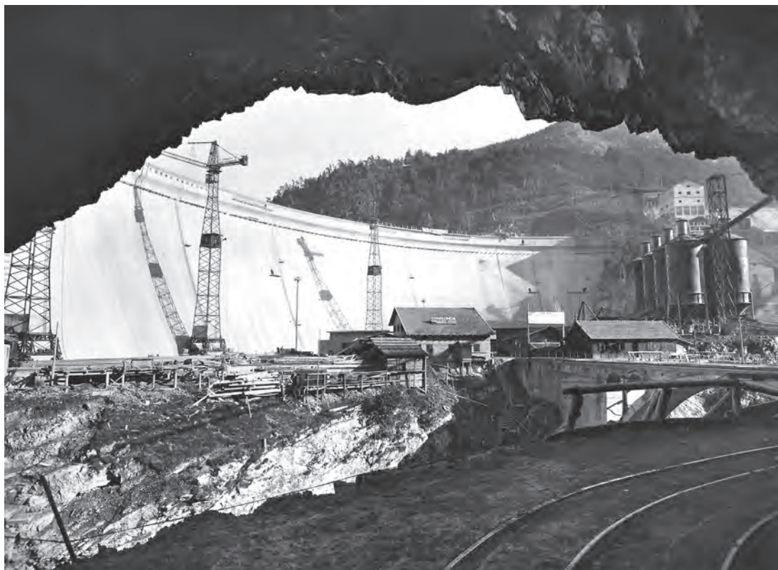
7. Lavori di costruzione della diga di Pieve di Cadore, anni Quaranta del Novecento, probabile documentazione dell'attività della Sade diretta al Genio civile (foto Ferruzzi; collezione privata).
