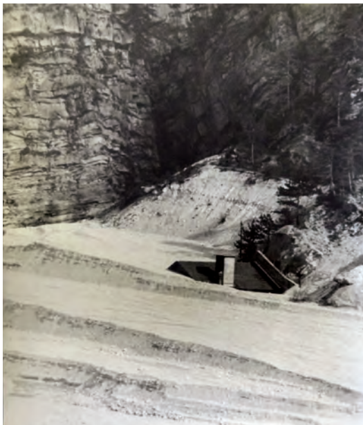
3. Effetti delle acque: la centrale di Valmontina dopo l'alluvione del novembre 1966 (Biblioteca storica cadorena di Vigo di Cadore, Archivio Fiorello Zangrando, b. XX, fasc. g).
